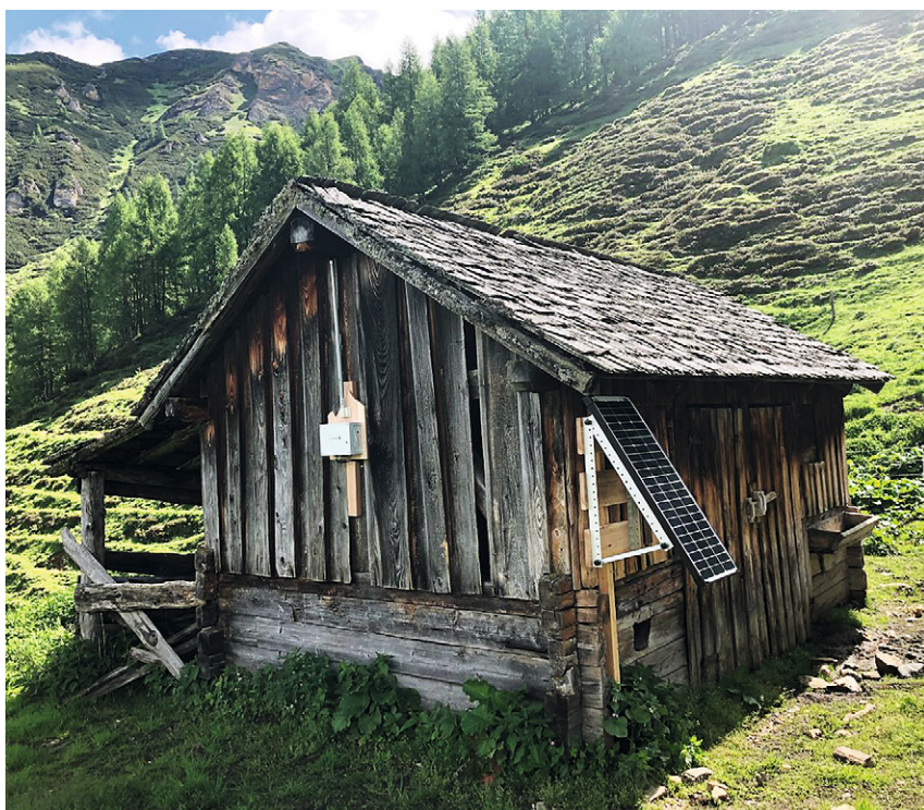
Bild 7: Per Solarzelle und Akku versorgtes Gateway
