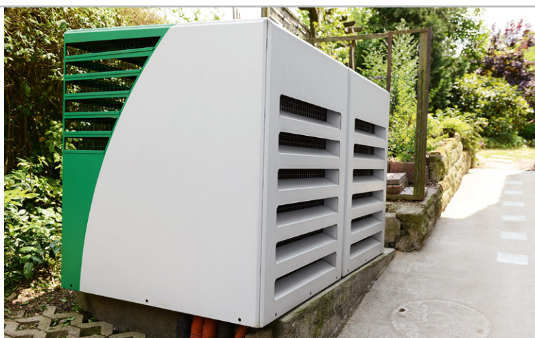
Bild 9: Je nach zu erbringender Heizleistung können die Schallemissionen von Luft-Wasser-Wärmepumpen in der nächsten Umgebung stören. Spezielle Lärmschutzgehäuse können Abhilfe schaffen. Bilder: Bundesverband Wärmepumpe e.V.
