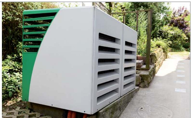
Bild 9: Je nach zu erbringender Heizleistung können die Schallemissionen von Luft-Wasser-Wärmepumpen in der nächsten Umgebung stören. Spezielle Lärmschutzgehäuse können Abhilfe schaffen. Bilder: Bundesverband Wärmepumpe e.V.
