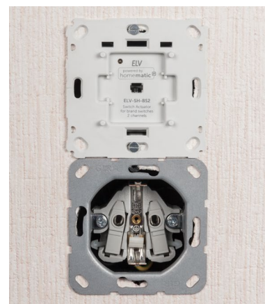
Bild 16: ... wird in die Installationsdose eingesetzt und verschraubt.
