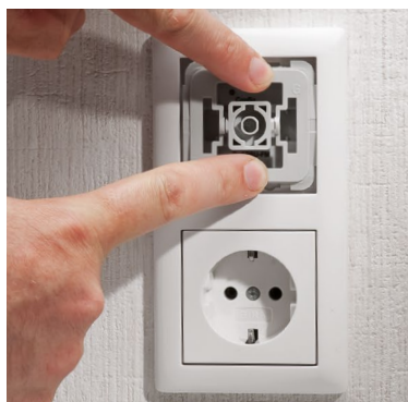
Bild 17: Der Abdeckrahmen des Installations-systems wird aufgesetzt.
