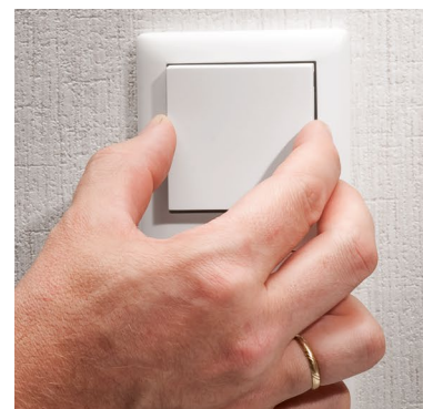
Bild 18: Abschluss der Installation: Einsetzen der Tasterwippe
