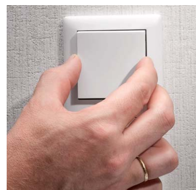
Bild 18: Abschluss der Installation: Einsetzen der Tasterwippe
