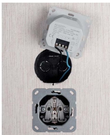
Bild 15: Der fertig verkabelte Wandsender ...
