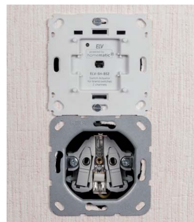
Bild 16: ... wird in die Installationsdose eingesetzt und verschraubt.
