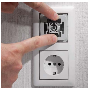
Bild 17: Der Abdeckrahmen des Installations-systems wird aufgesetzt.
