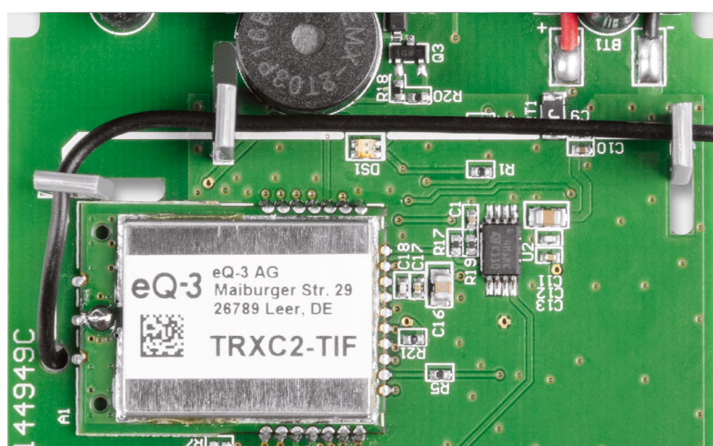
Bild 11: Die Verlegung der Antenne
