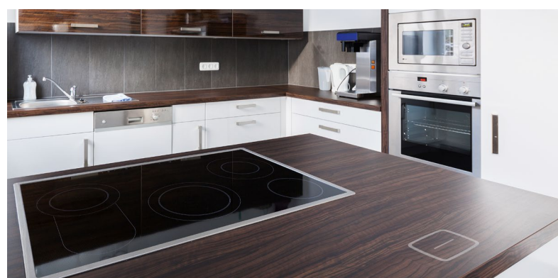
Bild 20: Der HmIP-STI unterhalb einer Küchenplatte mit der Klebefolie markiert
