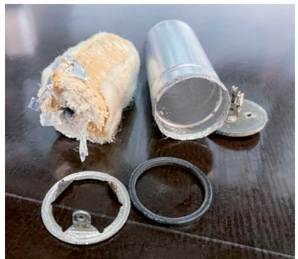
Bild 4: Der entfernte Teil des alten Kondensators
