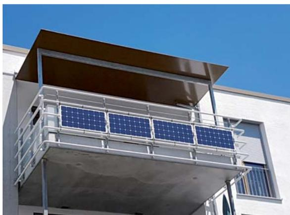
Bild 16: Typisches Balkonkraftwerk mit Montage der Solarmodule in der Balkonbrüstung, Bild: Energieagentur Kreis Konstanz
