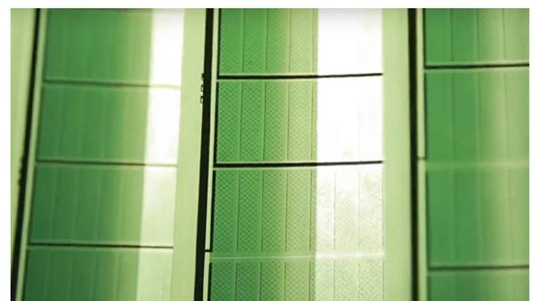
Bild 8: Suncourtain hat ein Gebäude-Verschattungssystem entwickelt, das auf OPV-Technik basiert. Bilder: Suncourtain
