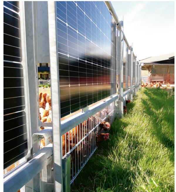
Bild 13: Bifaciale Solarmodule in eine Weidenumzäunung integriert, Bild: Next2Sun
