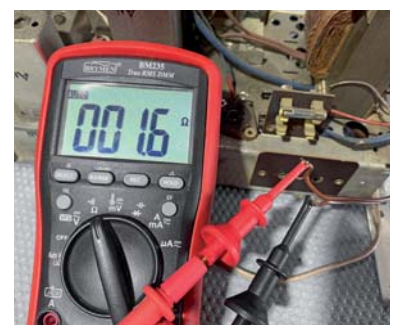
Bild 13: Messung des Widerstands der Sekundärseite des Ausgangstransformators, ohne dass ein Lautsprecher angeschlossen ist
