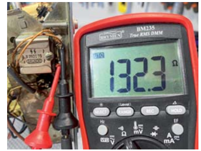
Bild 9: Messung des Widerstands der Leistungs-Sekundärseite des Leistungstransformators an den Eingängen des Brückengleichrichters
