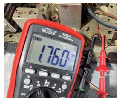
Bild 12: Messung des DC-Widerstands des Primärkreises des Ausgangstransformators
