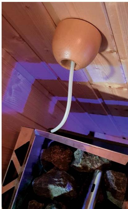
Bild 5: Silikonschlauch zum Rohr der Ofenbrause
