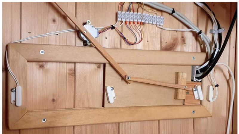
Bild 8: Lüftungsschieber
