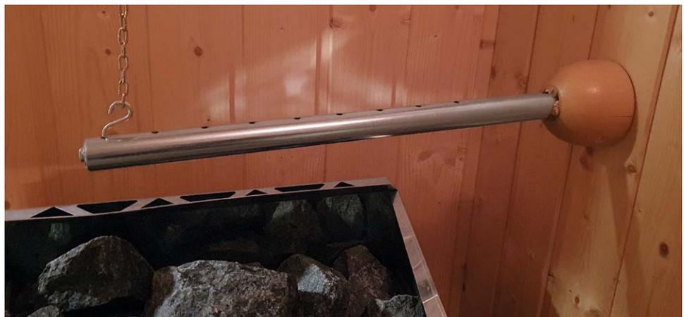
Bild 6: Ofenbrause mit Fixierung durch eine Kette am Ende des Stahlrohrs
