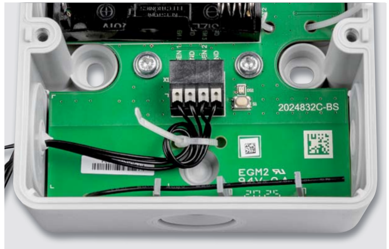
Bild 10: Durchführen der Temperatursensoren-Kabel und Montage in den Anschlussklemmen
