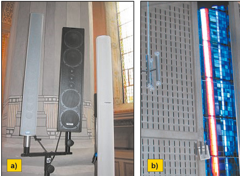
Bild 7: Akustik in Kirchen a) Lautsprecherzeilen zur gerichteten Beschallung in Kirchen b) Kirchenwände belegt mit Resonanzabsorbent zur Verringerung des Nachhalls
