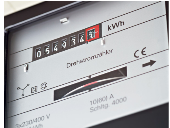
Bild 1: Ferraris-Zähler mit der drehenden Scheibe
