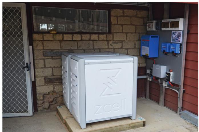
Bild 7: Kompakte Redox-Flow-Einheit an einer privaten Solaranlage mit zwei ZCell-Einheiten. Bild: Redflow
