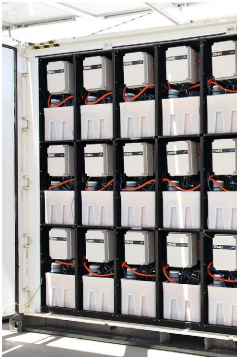
Bild 5: Eine Solar-Redox-Flow-Einheit in der Referenzanlage von Redflow mit 15 ZBM2.
