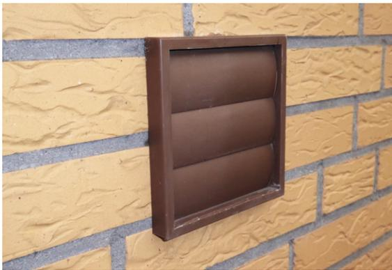
Bild 6: Günstige Entlüftungslösung – ein Abluftventilator in der Außenmauer
