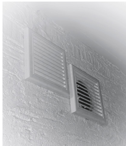
Bild 5: Ab- und Zuluftöffnung liegen dicht nebeneinander in der Außenwand und sind deshalb versetzt montiert. Zusätzlich sind die Zu- und Abluftrohre in der Wand mit leichtem Gefälle eingebaut, um entstehendes Kondensat nach außen abzuleiten. Außerdem wurden in den Luftkanälen Edelstahlrückschlagklappen installiert, um die Wärmedämmung zu verbessern.
