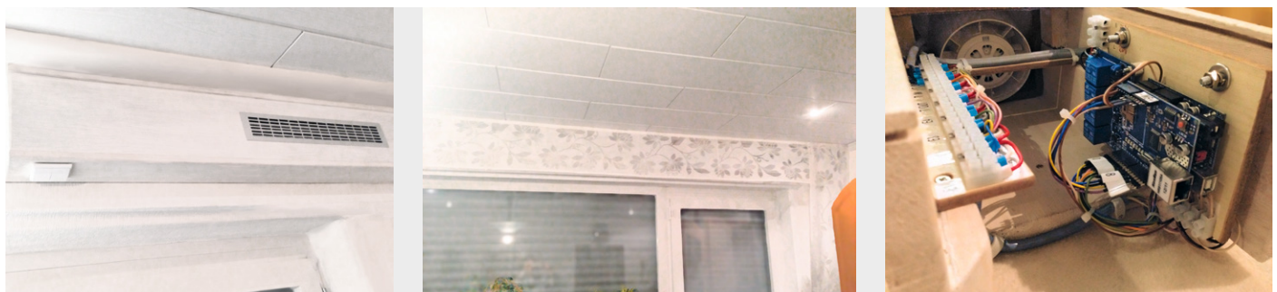
Bild 10: Die Montage des Wärmetauschers und der Steuerungskomponenten
