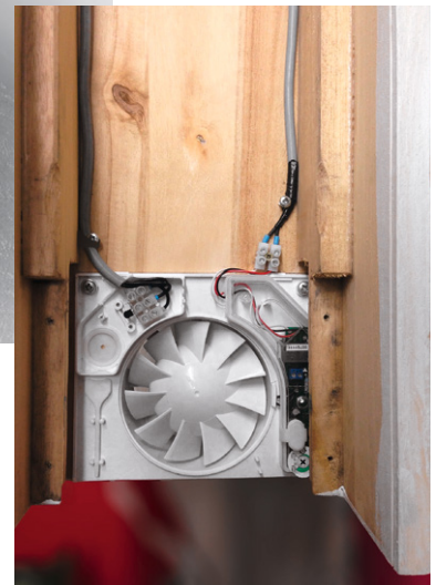
Bild 6: Der Abluftventilator ist am hinteren Ende im Gehäuseboden befestigt.
