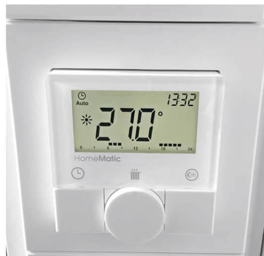
Bild 7: Zentrale Steuerungseinheit – der HomeMatic-Wandthermostat
