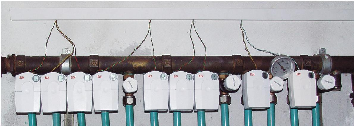
Bild 1: Der mit FHT-Ventilantrieben bestückte Heizkreisverteiler, Stand 2008
