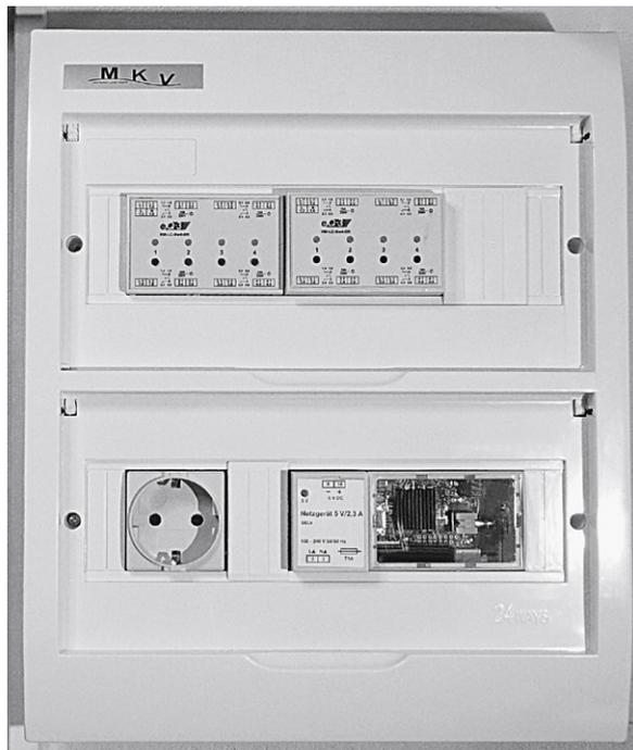
Bild 5: Genug Reserve für die komplette Umrüstung – die Schaltaktoren finden in einem Verteilergehäuse ihren Platz.
