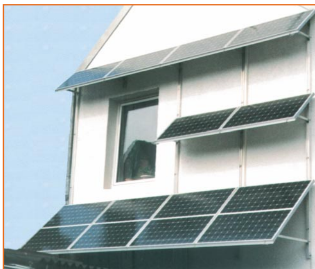
Bild 4: Keine Dachfläche Richtung Süden? Kein Problem - die Fassadenmontage ist genauso möglich. Foto: Solar-Technik Nord
