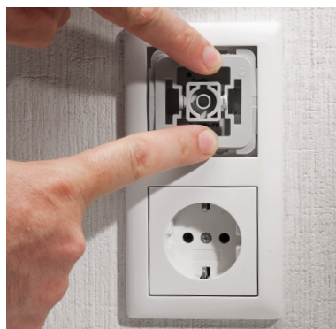
Bild 17: Der Abdeckrahmen des Installationsystems wird aufgesetzt.
