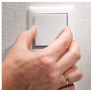
Bild 18: Abschluss der Installation: Einsetzen der Tasterwippe
