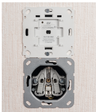
Bild 16: ... wird in die Installationsdose eingesetzt und verschraubt.
