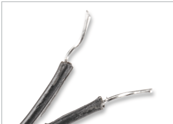
Bild 8: Auftrennen und Abisolieren der Zwillingskabel am Ende
