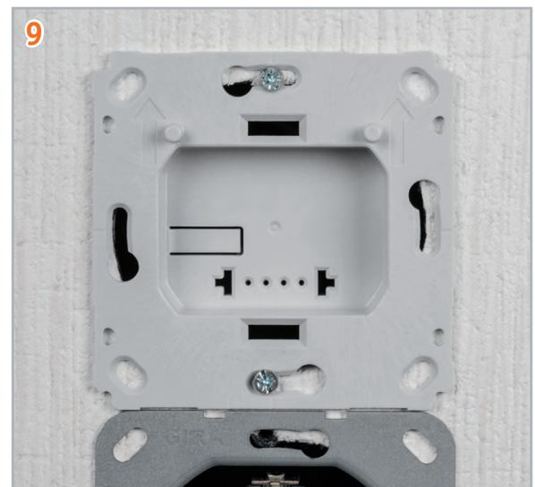
Schritt 9: Befestigen der Montageplatte in einer 55er-Installationsdose
