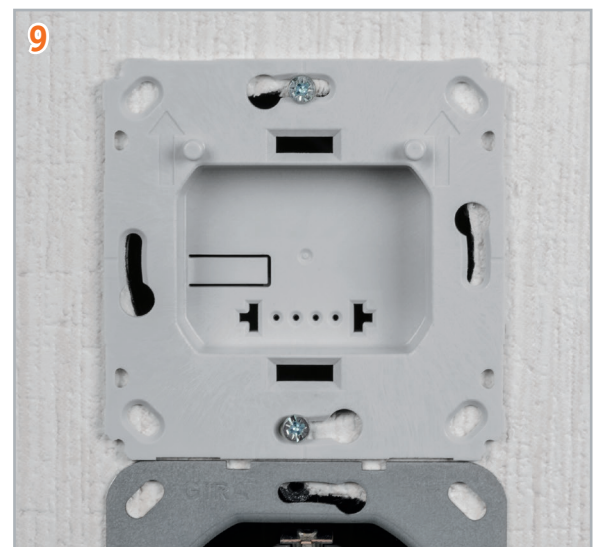
Schritt 9: Befestigen der Montageplatte in einer 55er-Installationsdose
