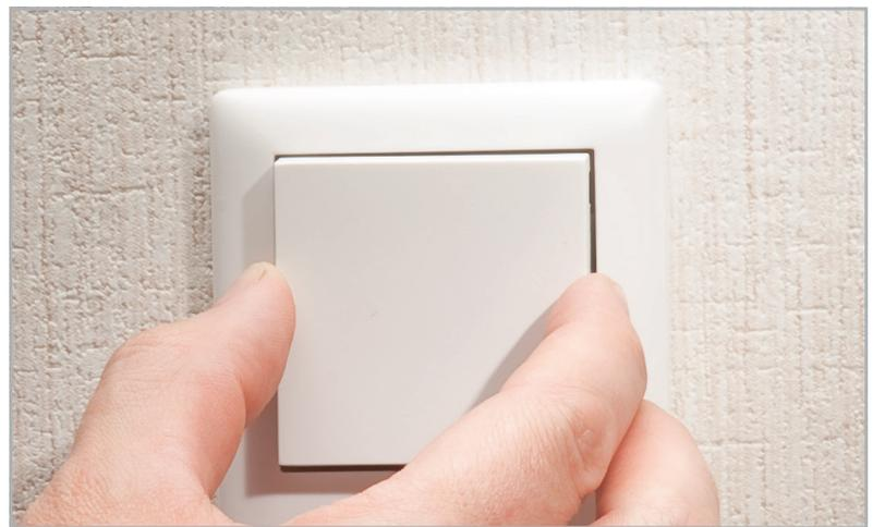
Bild 12: Der Abschluss der Installation: Einsetzen der Tasterwippe
