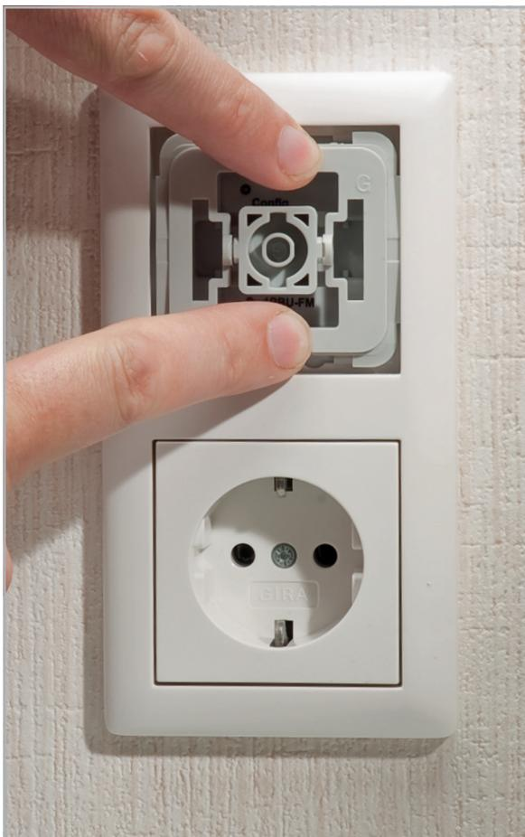
Bild 11: Der Abdeckrahmen des Installationssystems und der Wippenadapter werden aufgesetzt.
