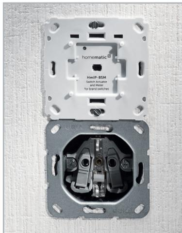
Bild 16: ... wird in die Installationsdose eingesetzt und verschraubt.
