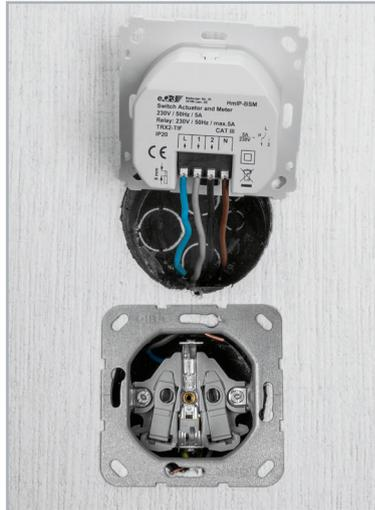
Bild 15: Der fertig verkabelte Aktor ...
