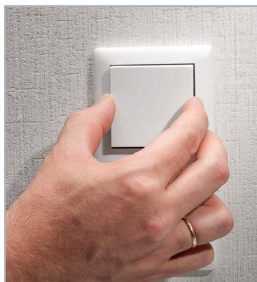
Bild 18: Abschluss der Installation: Einsetzen der Tasterwippe
