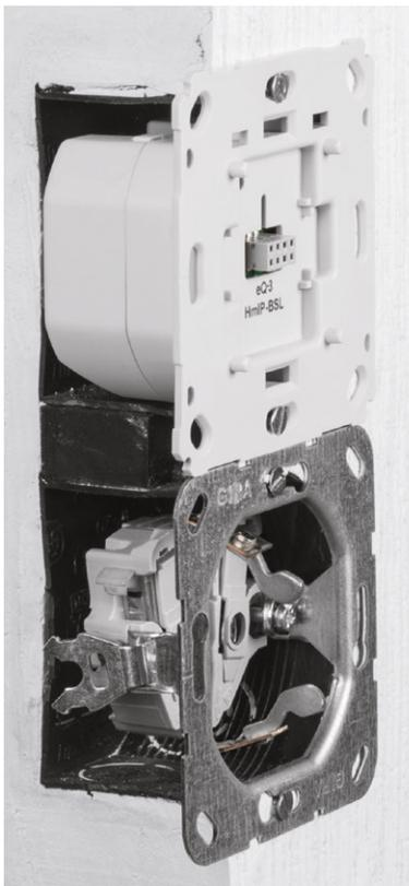
Bild 25: So erfolgt die Montage in eine Unterputzdose.
