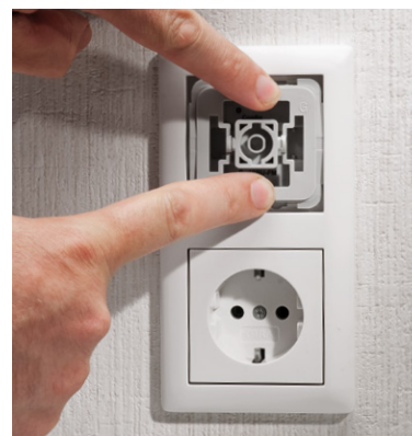
Bild 17: Der Abdeckrahmen des Installationssystems wird aufgesetzt.
