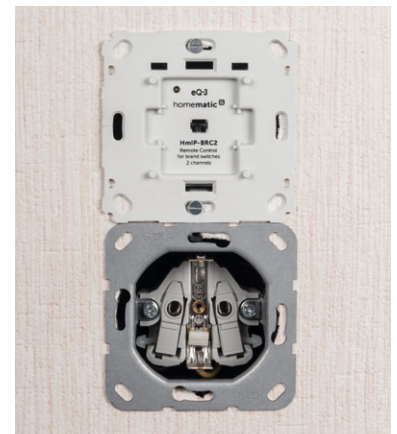
Bild 16: ... wird in die Installationsdose eingesetzt und verschraubt.
