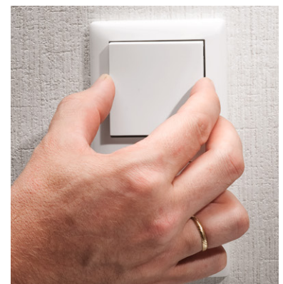
Bild 18: Abschluss der Installation: Einsetzen der Tasterwippe
