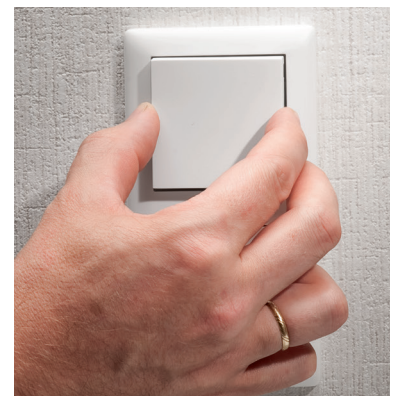
Bild 18: Abschluss der Installation: Einsetzen der Tasterwippe
