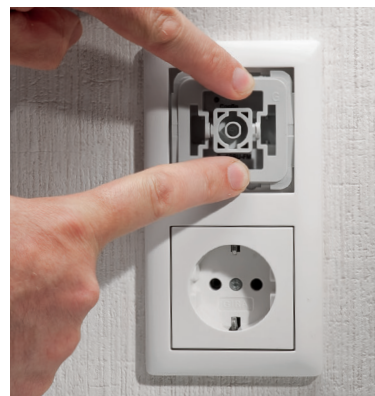
Bild 17: Der Abdeckrahmen des Installationssystems wird aufgesetzt.
