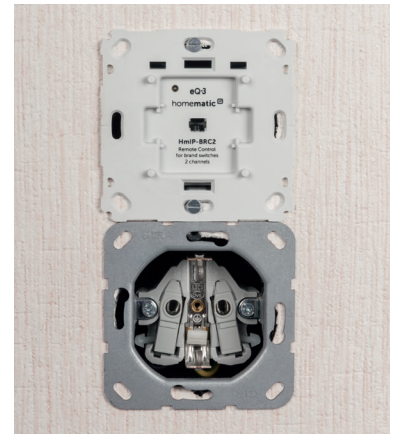
Bild 16: ... wird in die Installationsdose eingesetzt und verschraubt.
