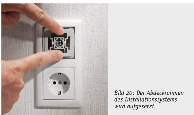
Bild 20: Der Abdeckrahmen des Installationssystems wird aufgesetzt.
