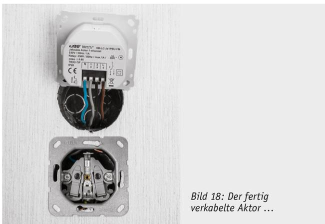
Bild 18: Der fertig verkabelte Aktor ...
