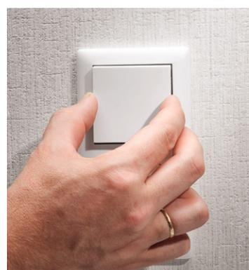
Bild 21: Abschluss der Installation: Einsetzen der Tasterwippe
