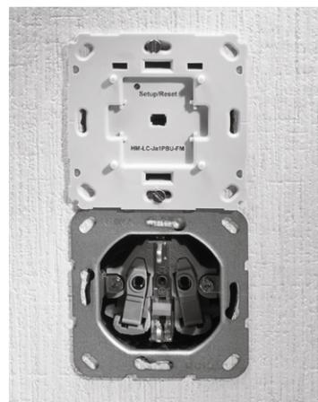
Bild 19: ... wird in die Installationsdose eingesetzt und verschraubt.
