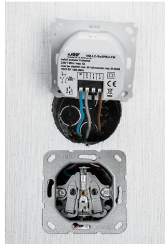
Bild 22: Der fertig verkabelte Aktor ...
