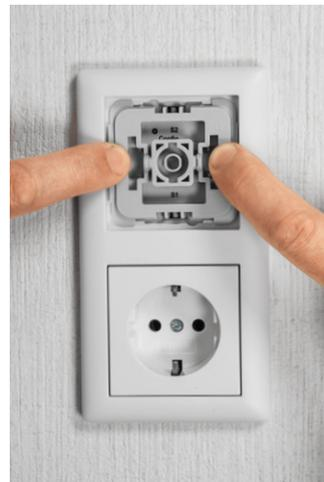
Bild 24: Der Abdeckrahmen des Installationssystems wird aufgesetzt.
