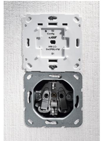
Bild 23: ... wird in die Installationsdose eingesetzt und verschraubt.
