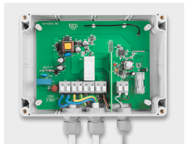
Bild 7: Die in das Gehäuse montierte Platine wird mit den Kunststoff-Abstandhaltern befestigt. Hier sind auch die Lage der Kabeldurchführungen sowie die Verkabelung zu sehen.
