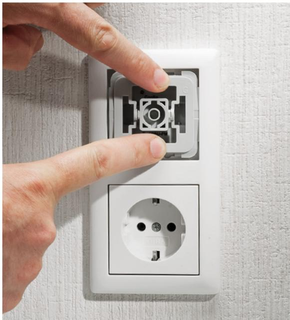
Bild 17: Der Abdeckrahmen des Installationssystems wird aufgesetzt.
