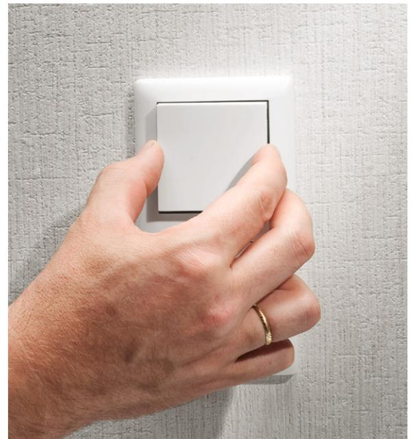
Bild 18: Abschluss der Installation: Einsetzen der Tasterwippe
