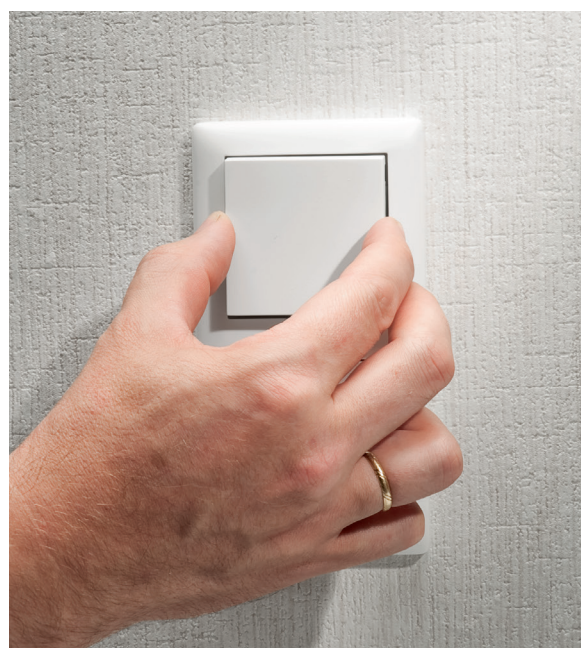
Bild 18: Abschluss der Installation: Einsetzen der Tasterwippe
