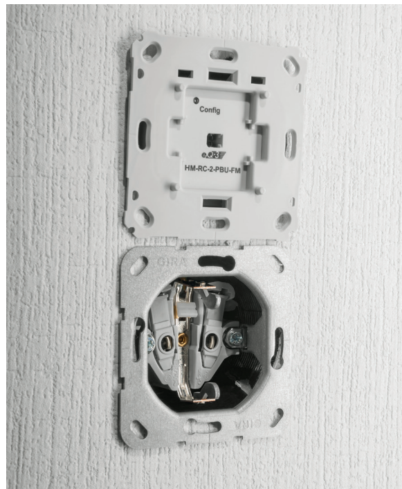
Bild 16: ... wird in die Installationsdose eingesetzt und später verschraubt.
