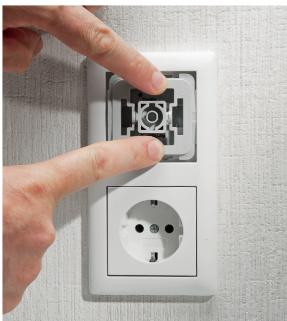
Bild 17: Der Abdeckrahmen des Installationssystems wird aufgesetzt.
