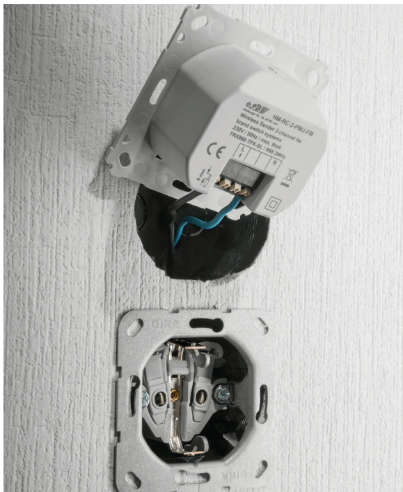
Bild 15: Der fertig verkabelte Aktor ...
