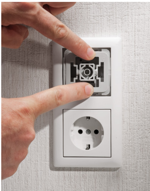
Bild 18: Der Wippenadapter des Installationssystems wird aufgesetzt.
