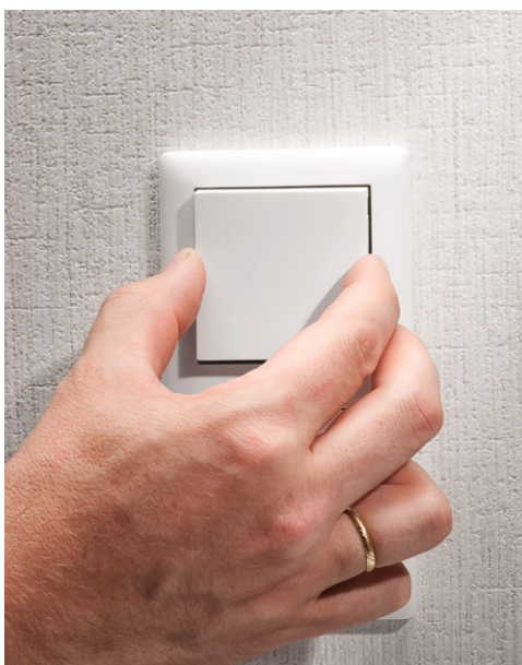
Bild 19: Abschluss der Installation: Einsetzen der Tasterwippe
