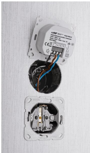
Bild 20: Der fertig verkabelte Aktor ...
