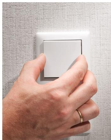
Bild 23: Abschluss der Installation: Einsetzen der Tasterwippe
