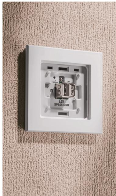
Bild 30: Montage des Abdeckrahmens
