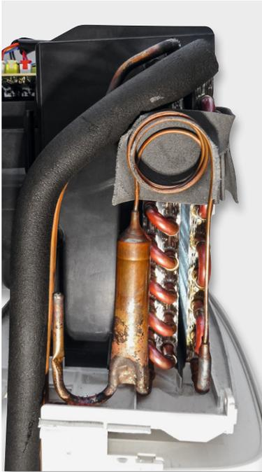
Bild 6: Hier ist das druckmindernde Kapillarrohr zu sehen.
