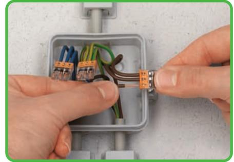
Anschließen: Abisolierten eindrängigen Leiter bis zum Anschlag einstecken.
