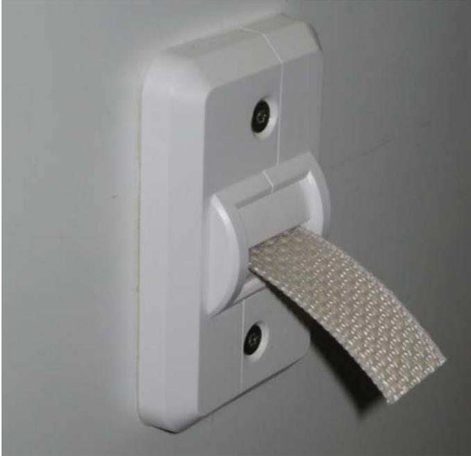
**Bild 3** Detail Gurtführung mit Dichtplatte
