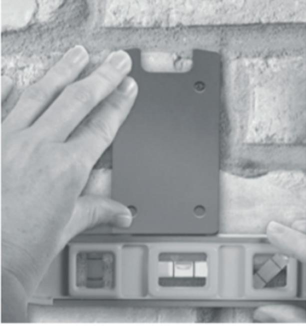
**1.** Positionieren Sie die Metallmontageplatte auf der gewünschten Oberfläche.
