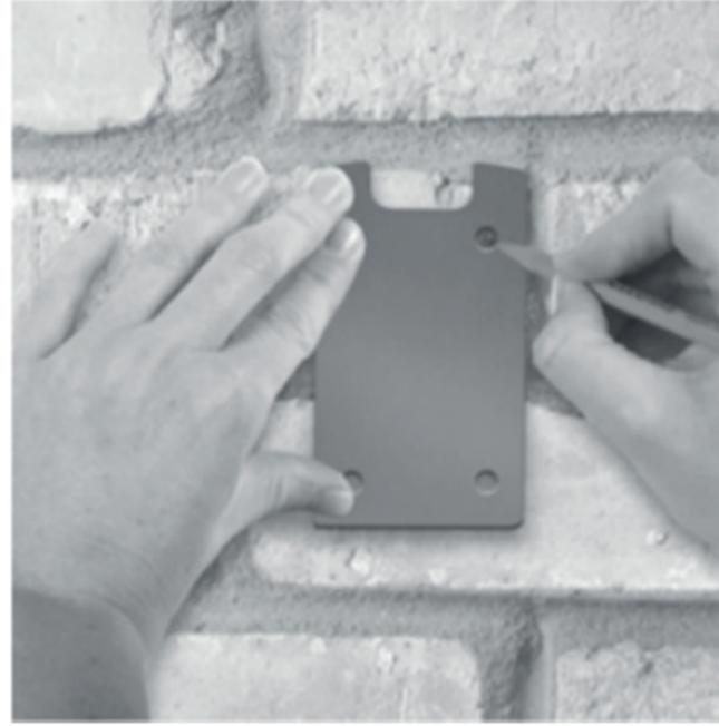
**2.** Markieren Sie die Position der Schraubenlöcher.
