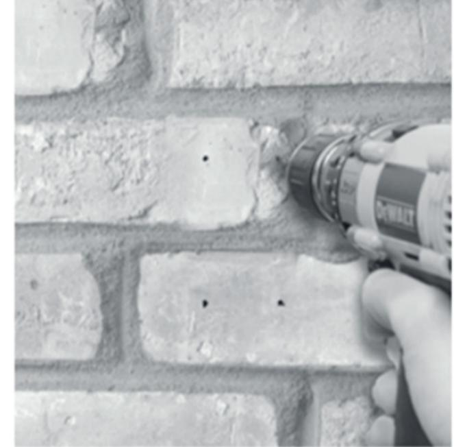
**3.** Platte entfernen. Löcher bohren und Dübel setzen.
