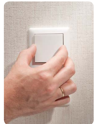
Bild 17: Abschluss der Installation: Einsetzen der Tasterwippe
