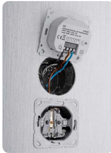
Bild 14: Der fertig verkabelte Timer ...
