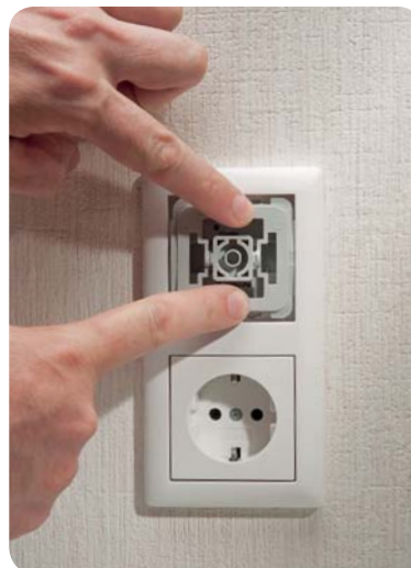
Bild 16: Der Abdeckrahmen des Installationssystems wird aufgesetzt.
