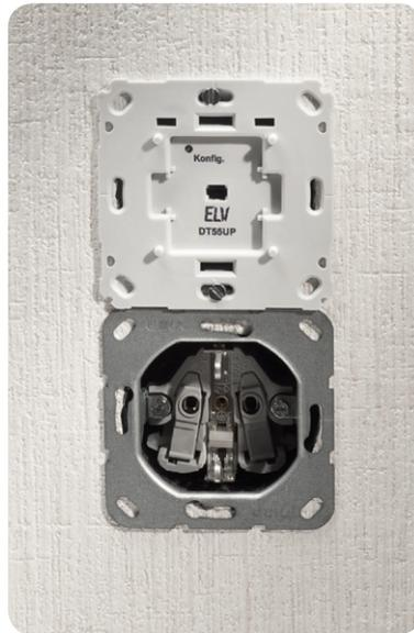
Bild 21: ... wird in die Installationsdose eingesetzt und verschraubt.
