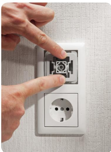
Bild 22: Der Abdeckrahmen des Installationssystems wird aufgesetzt.
