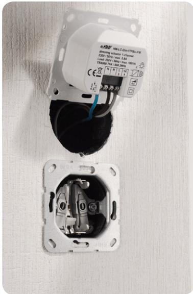
Bild 20: Der fertig verkabelte Dimmer ...
